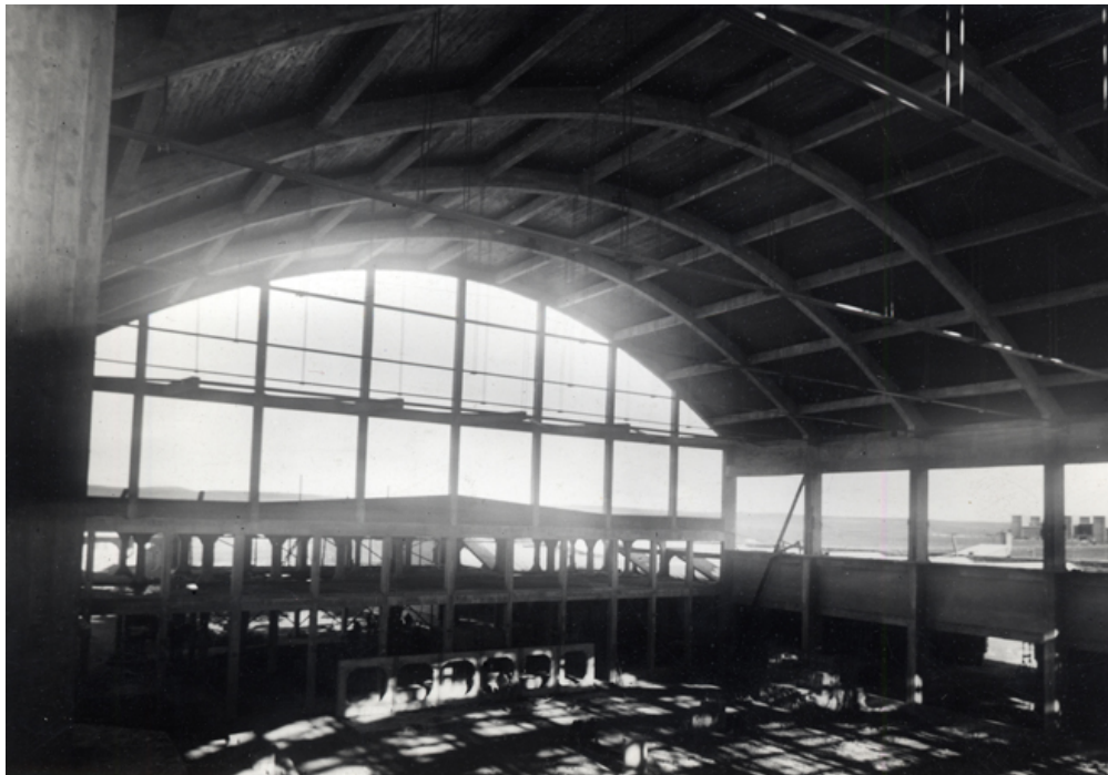
Vista interior del taller en construcción
