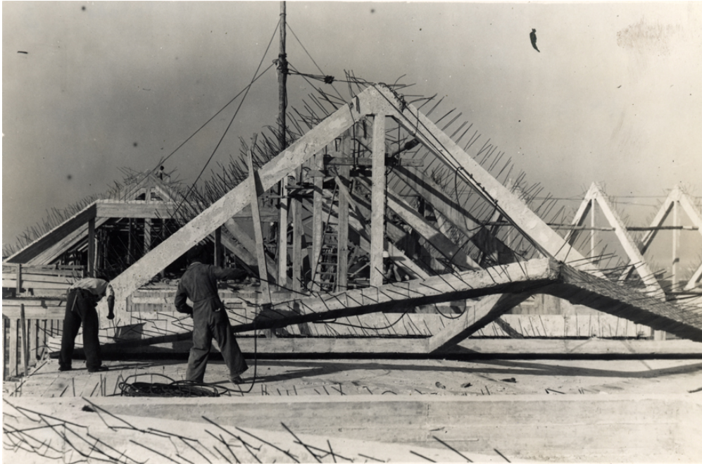
Cubierta en construcción
