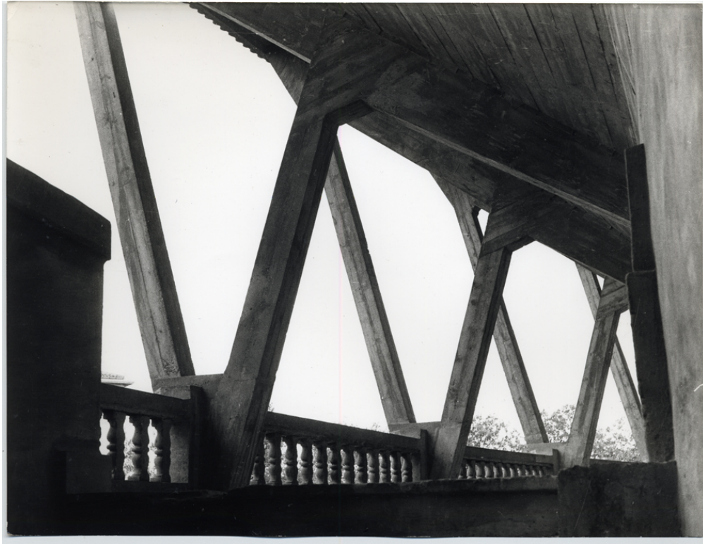
Detalle de construcción
