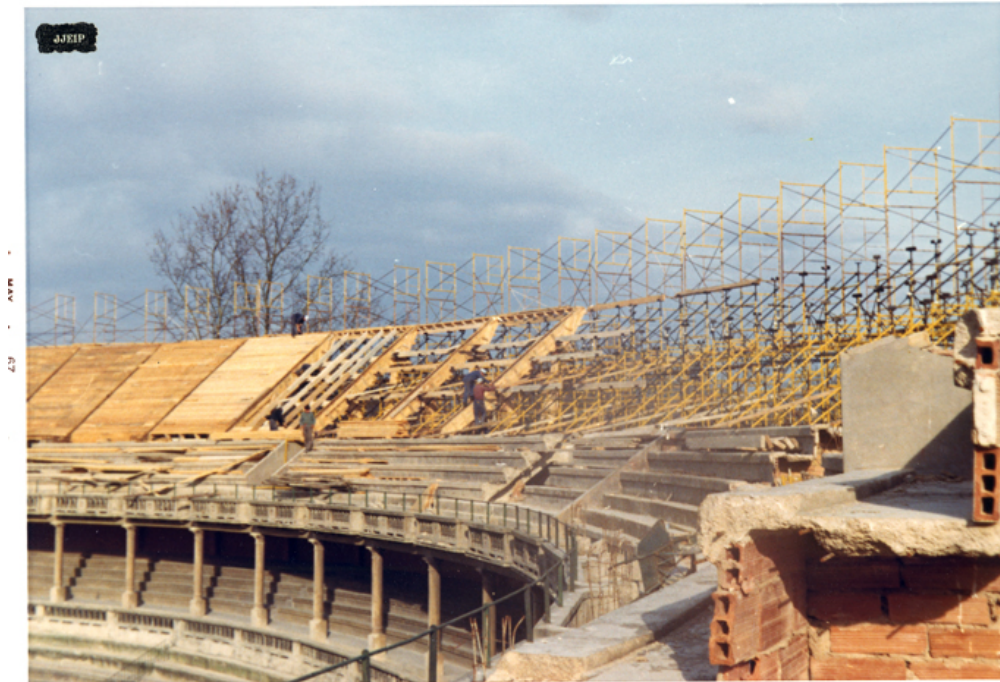
Vista interior de la plaza en construcción
