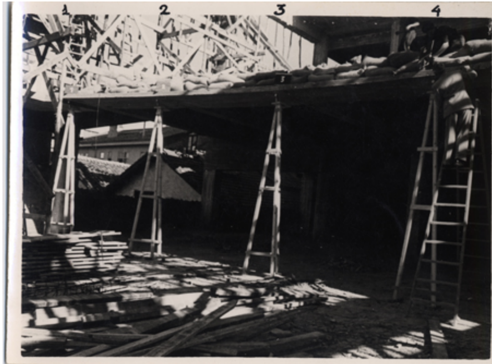
Vista trabajos de construcción
