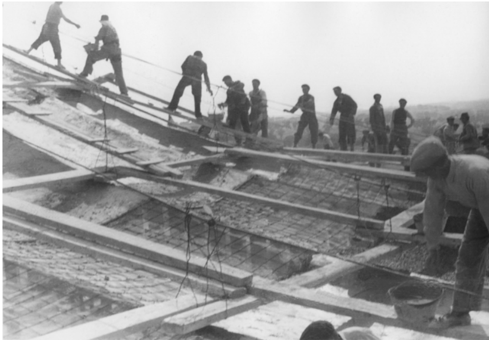
Vista obreros trabajando en la cubierta
