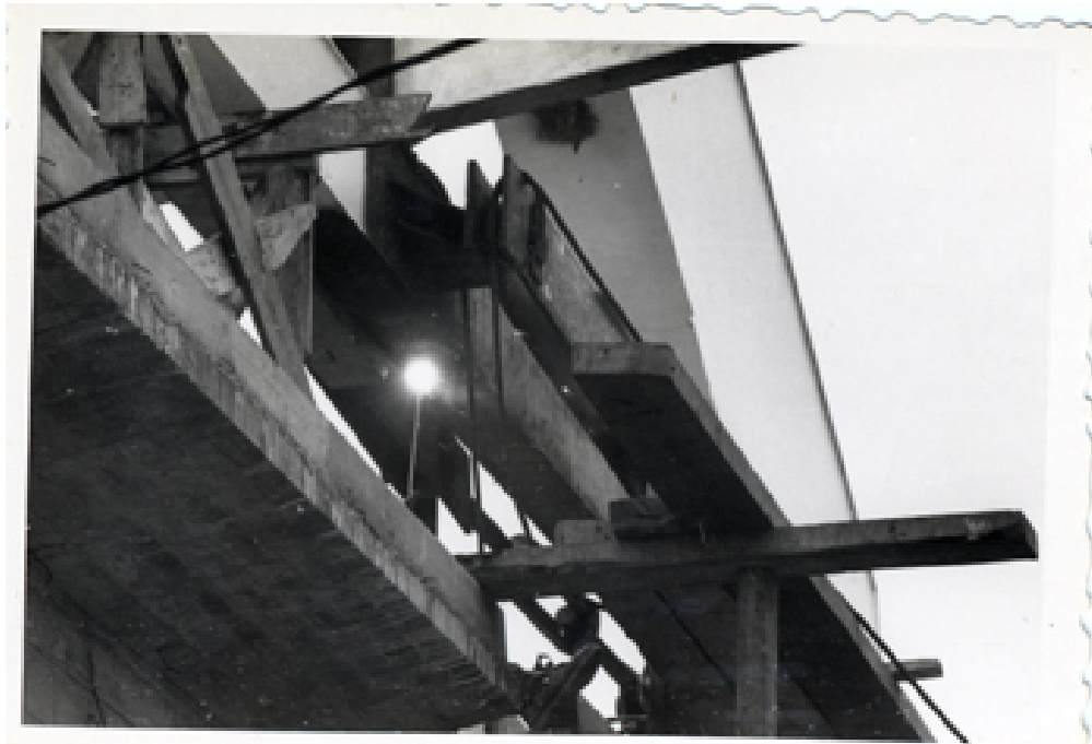
Detalle de construcción
