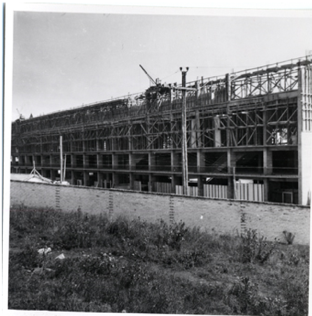
Vista del estadio en construcción
