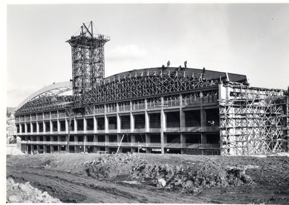
Vista del estadio en construcción
