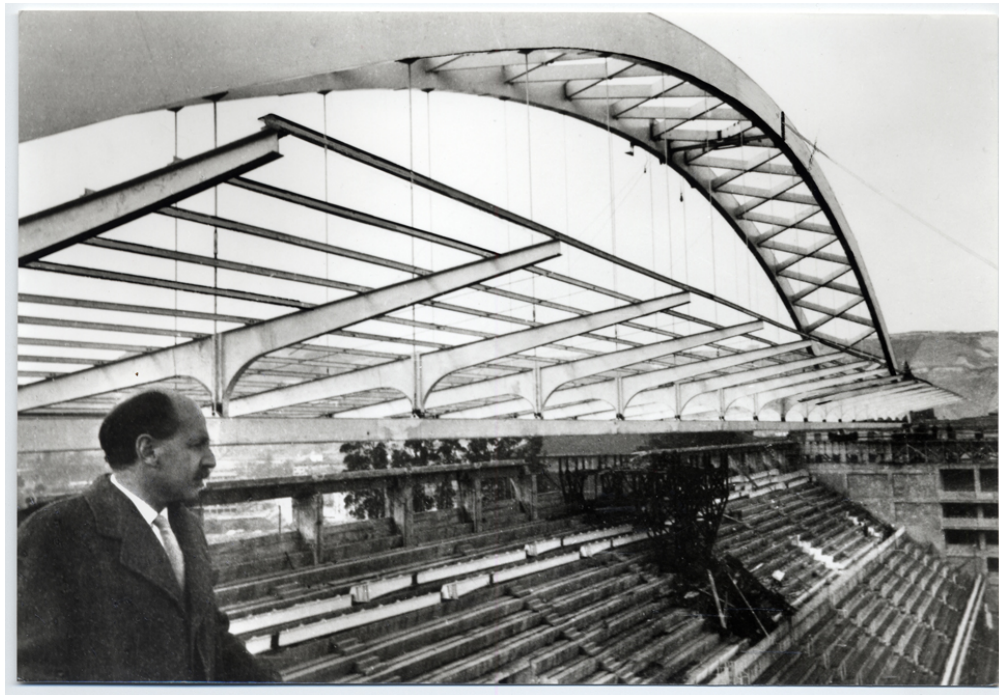
Carlos Fernández Casado contemplando el estadio en construcción
