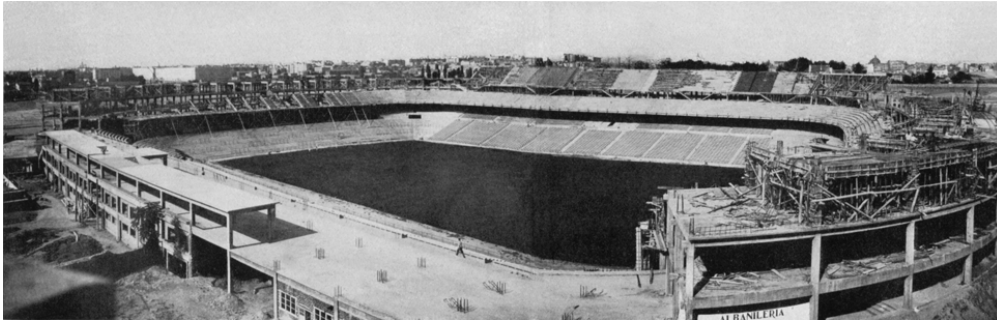
Vista del estadio en construcción
