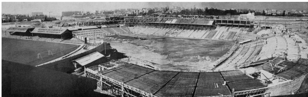
Vista del estadio en construcción
