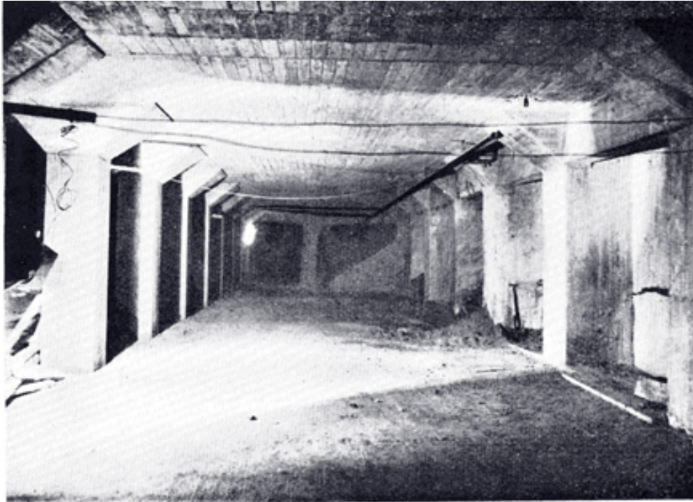
Detalle del interior del edificio en construcción
