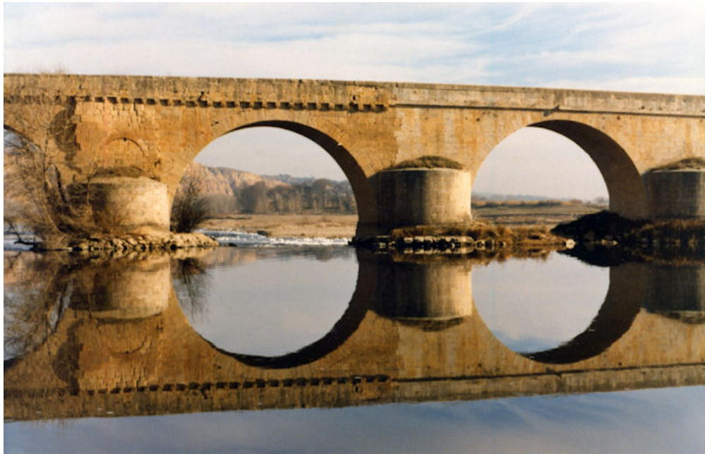
Vista del puente
