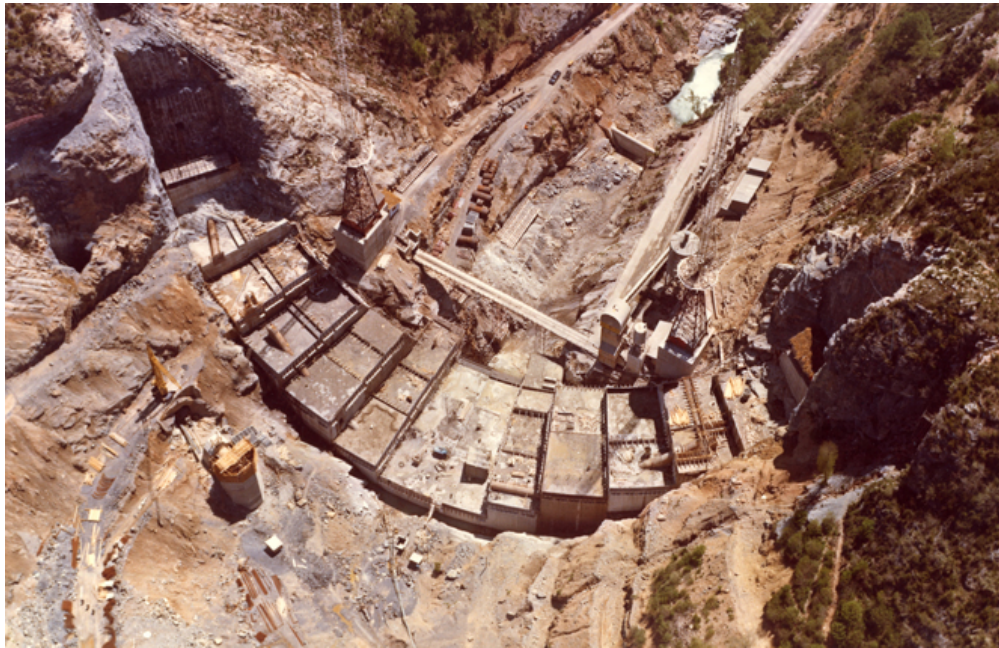
Vista aérea de la presa en construcción
