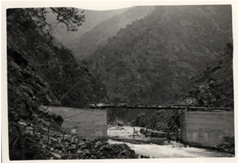
Vista de la presa en construcción
