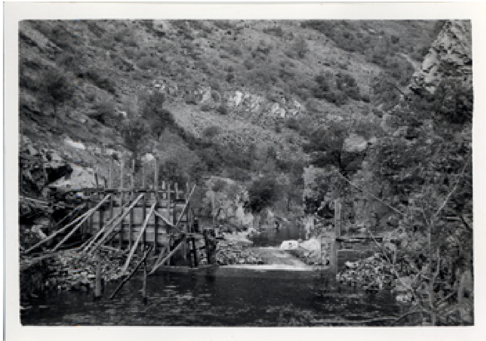
Detalle de la presa en construcción
