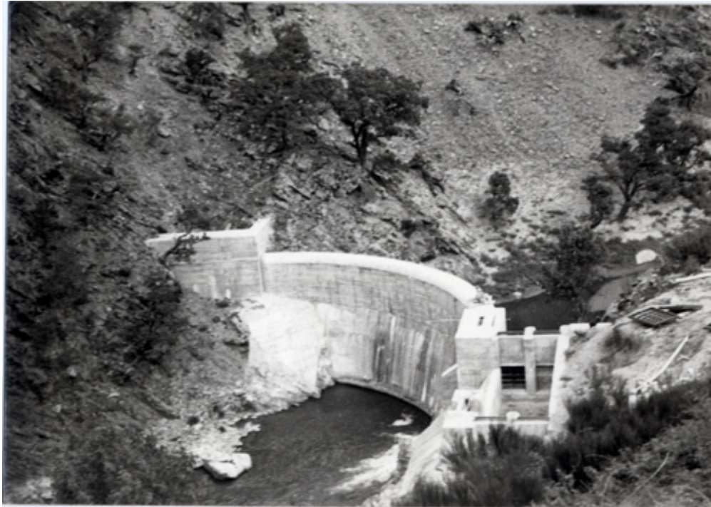
Vista aérea de la presa
