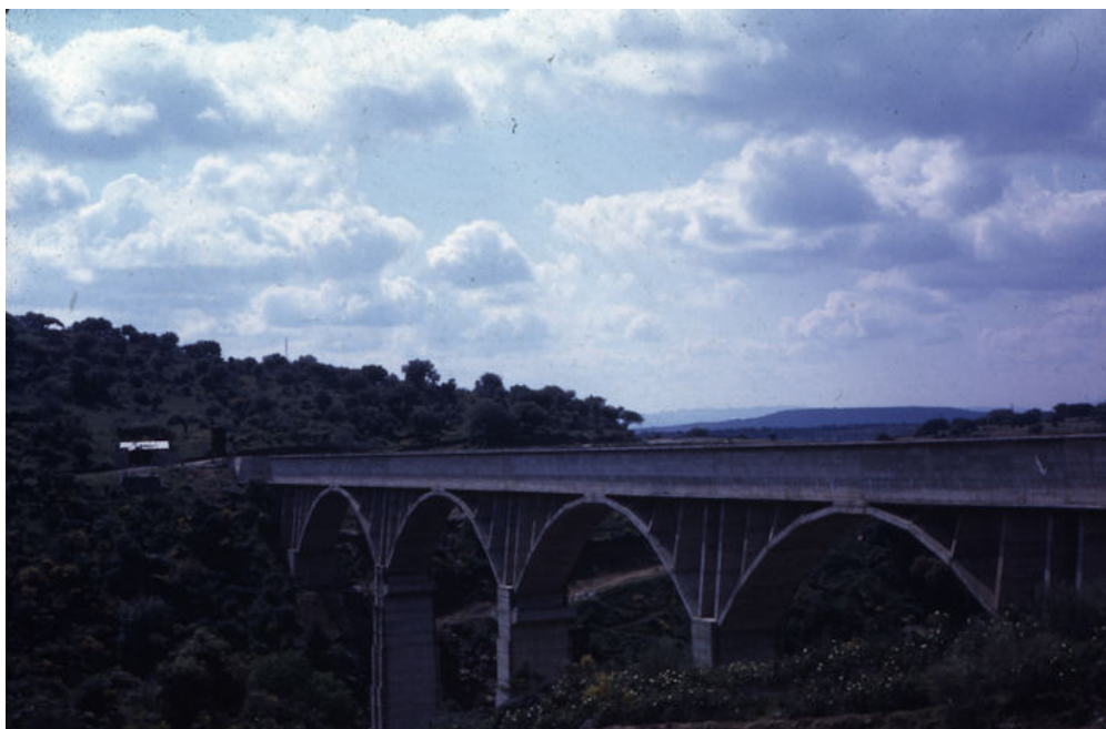
Vista del acueducto
