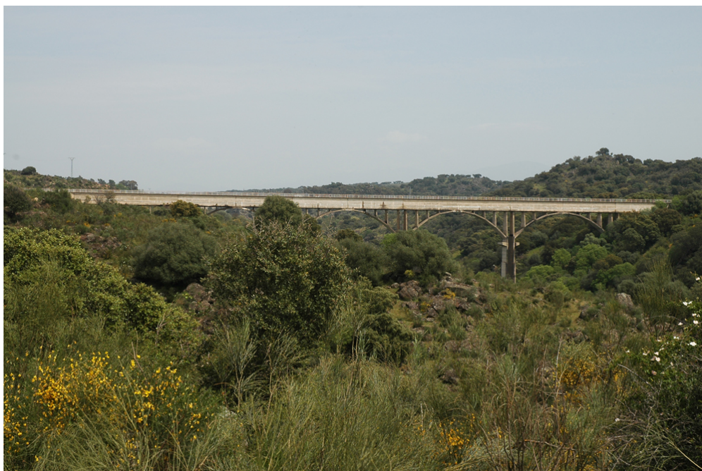
Vista del puente
