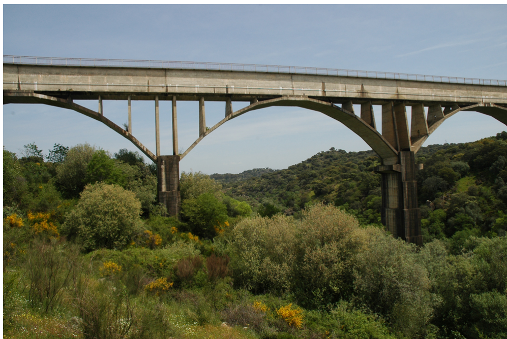
Vista del acueducto
