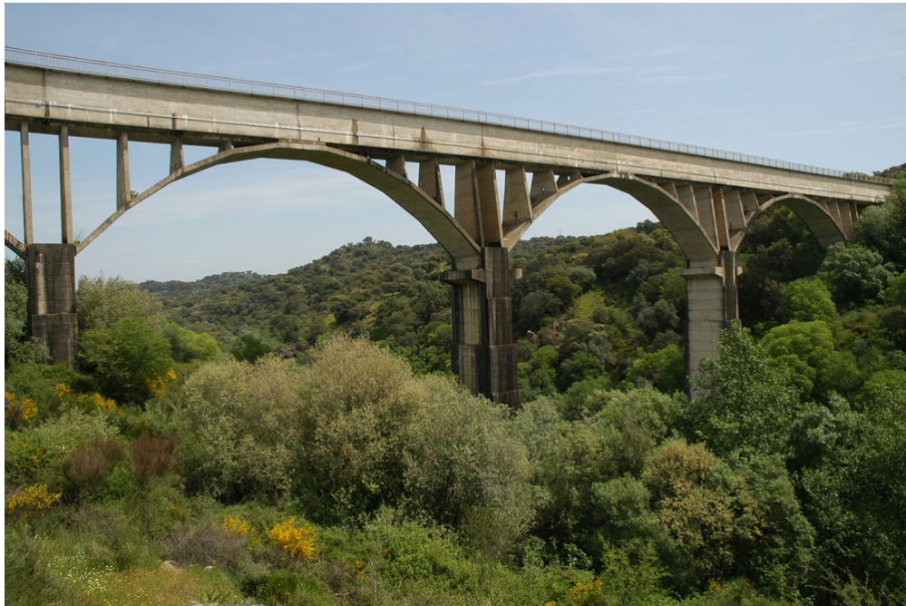
Vista del acueducto
