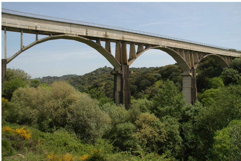
Vista del acueducto
