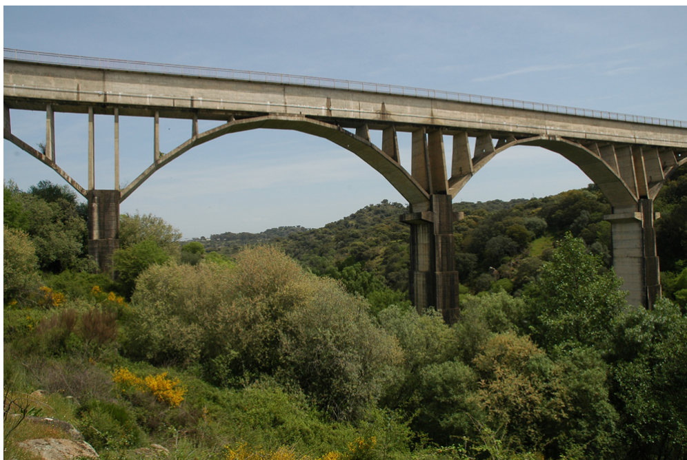
Vista del acueducto
