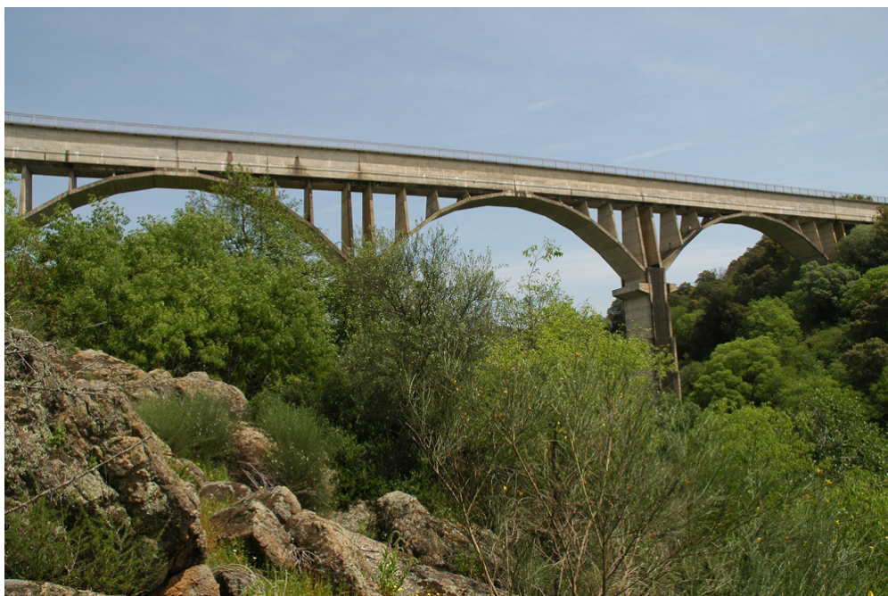
Vista del acueducto
