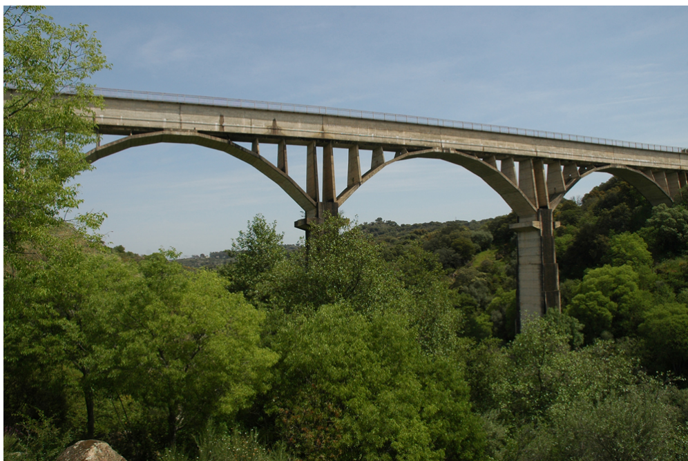
Vista del acueducto
