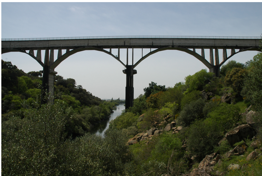
Vista del acueducto
