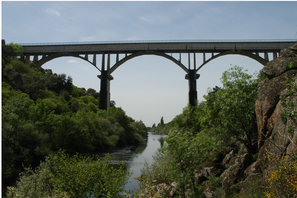
Vista del acueducto
