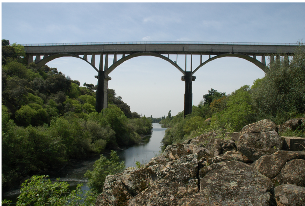
Vista del acueducto
