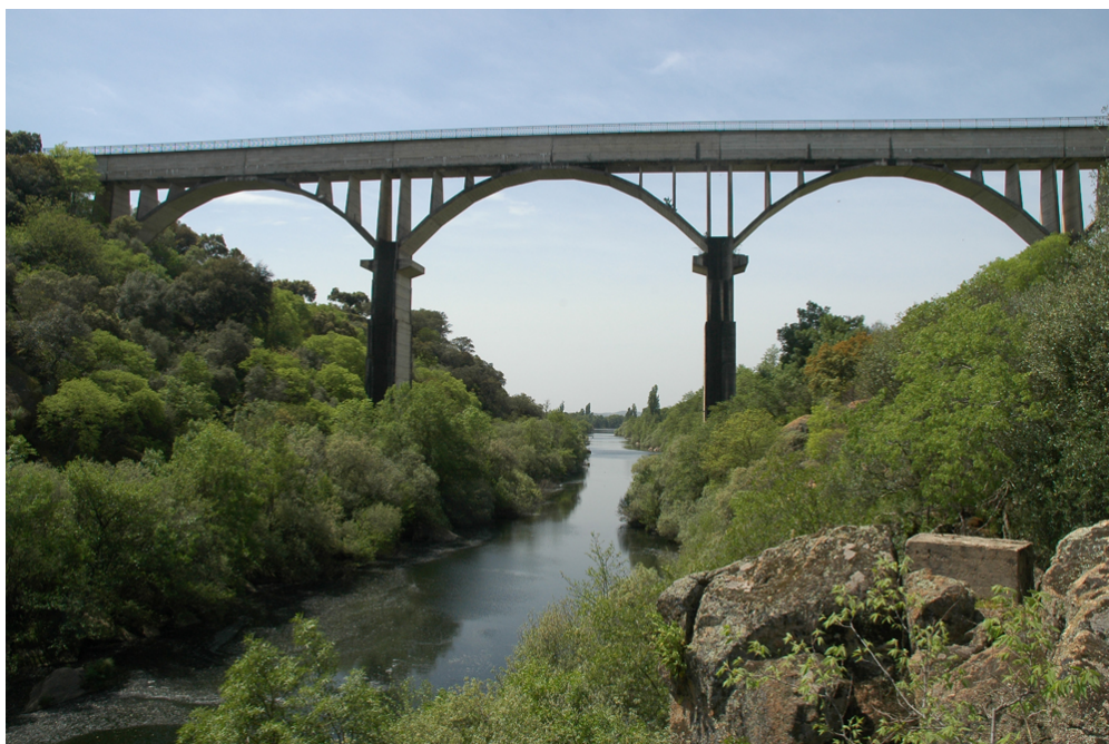
Vista del acueducto
