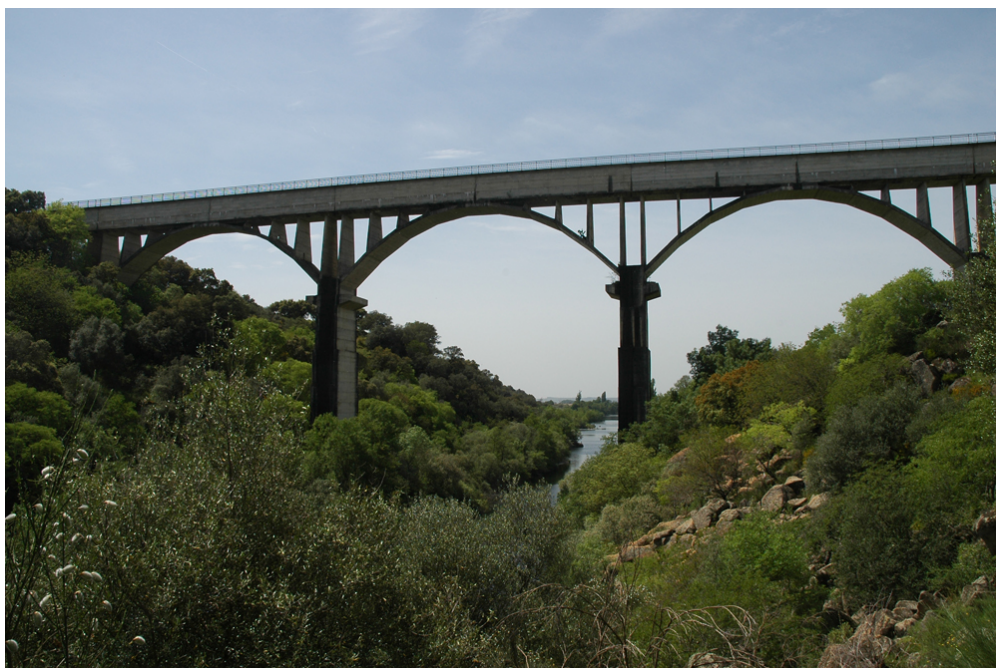
Vista del acueducto
