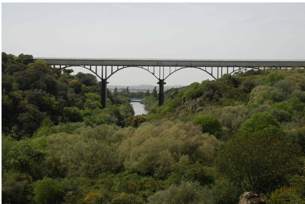
Vista del acueducto
