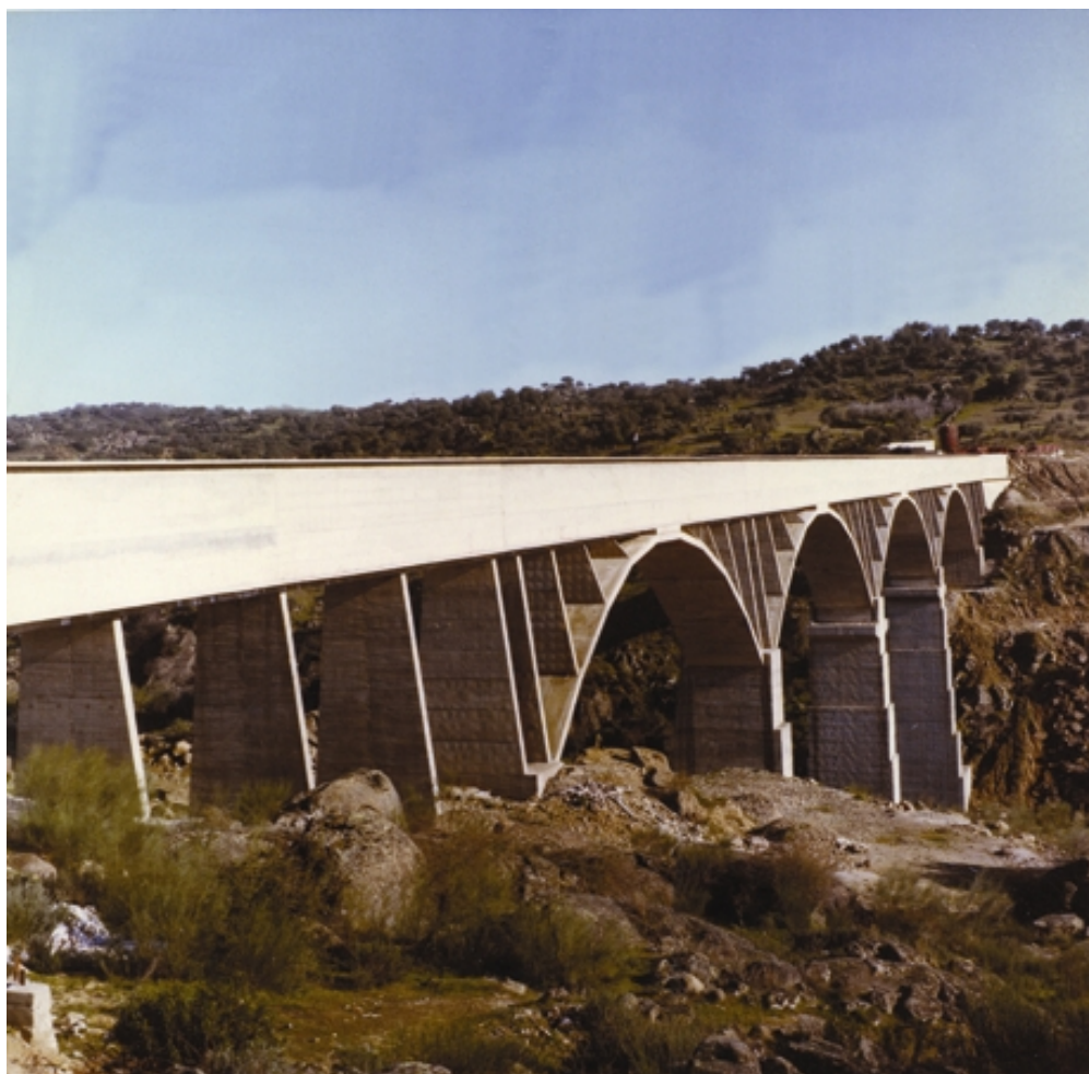
Vista del puente ya terminado
