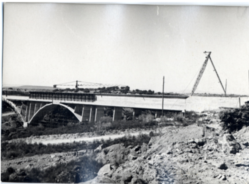
Construcción del tablero
