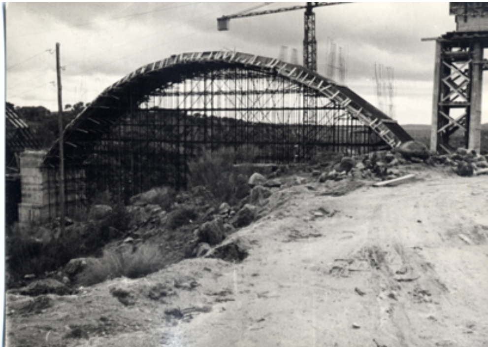
Estructura de madera de uno de los arcos durante su construcción
