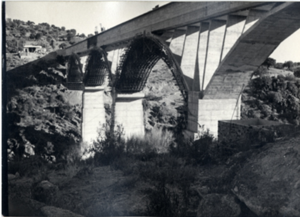
Puente en construcción con cerchas de madera en los arcos
