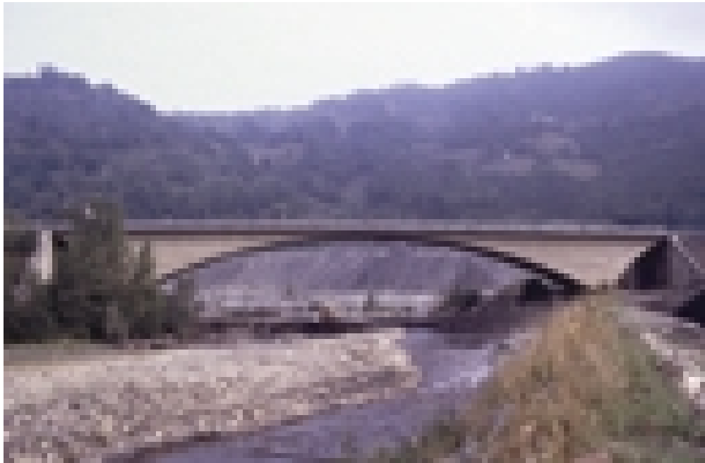
Vista del puente
