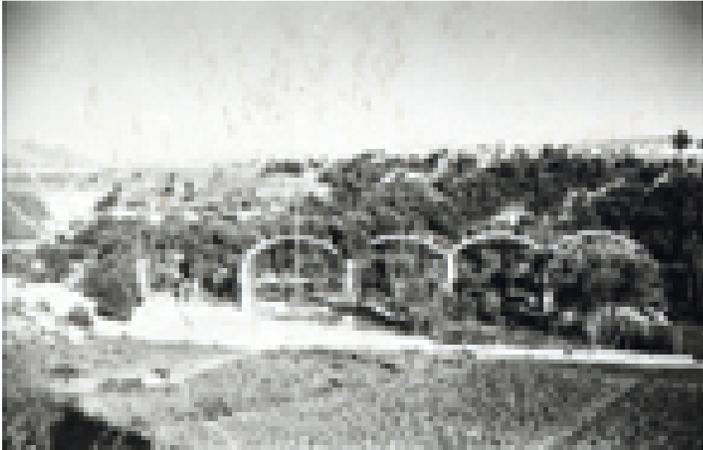
Vista del acueducto en construcción
