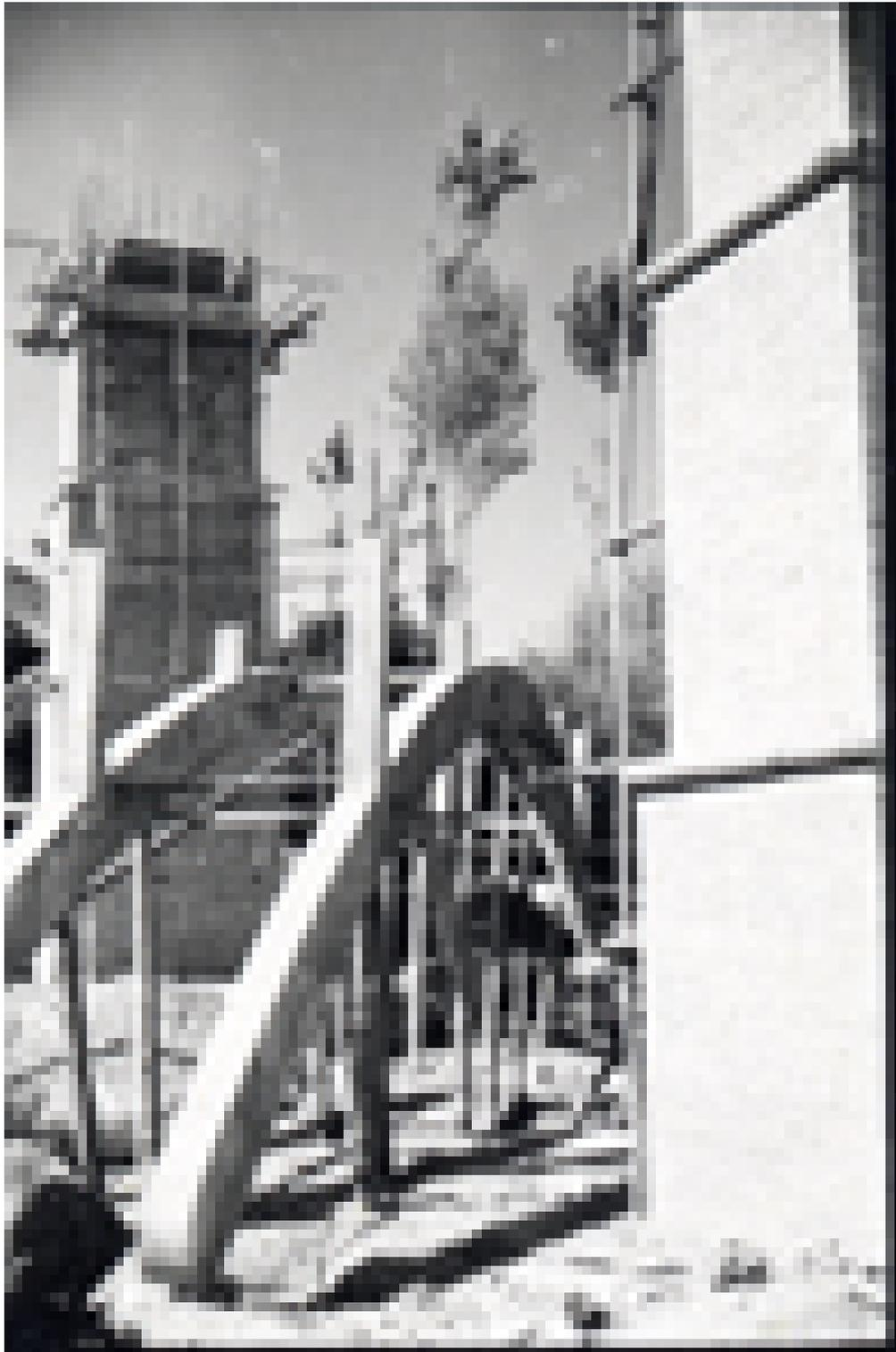
Estructura de un arco apoyada en el suelo
