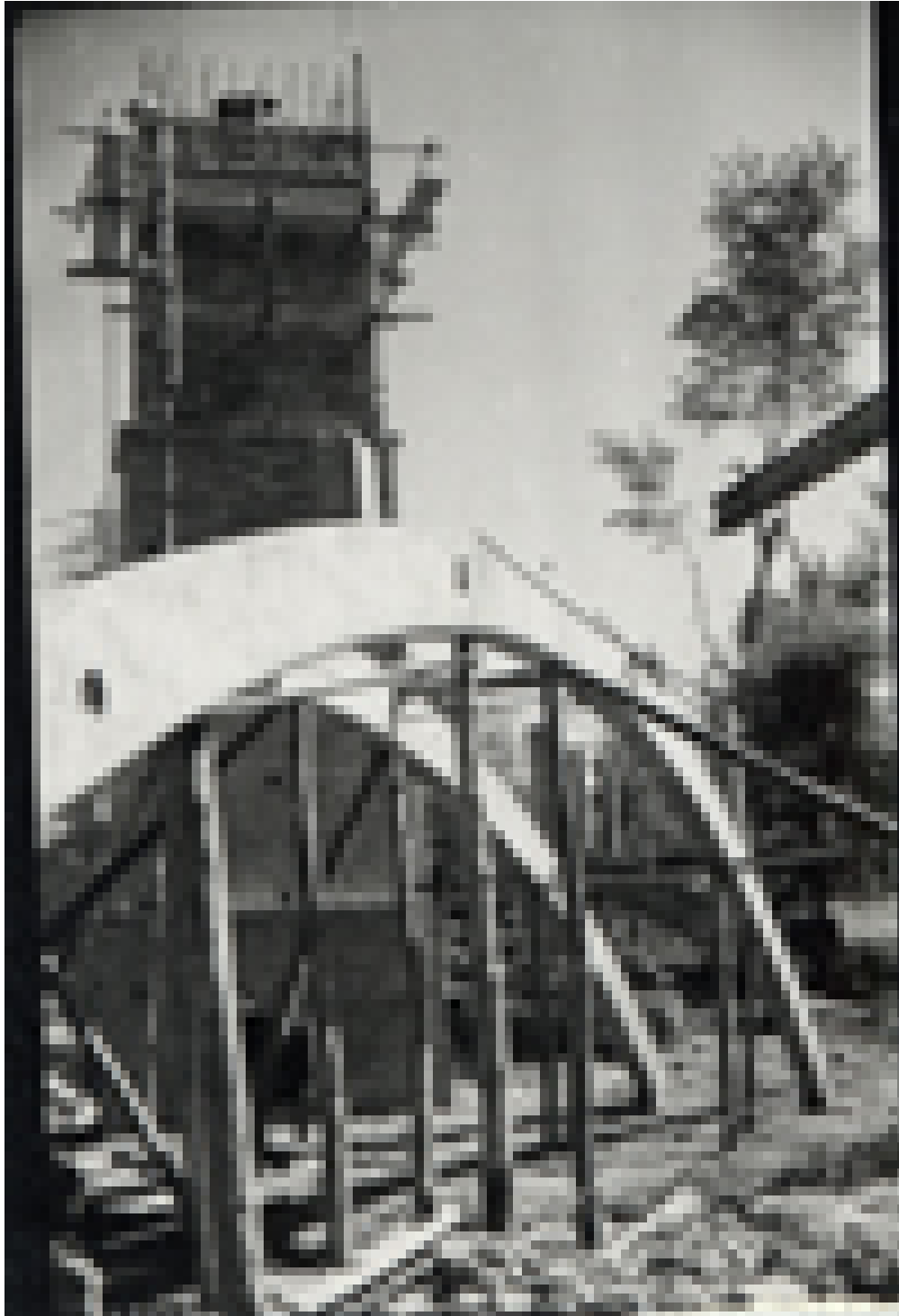
Estructura de los arcos apoyadas en el suelo
