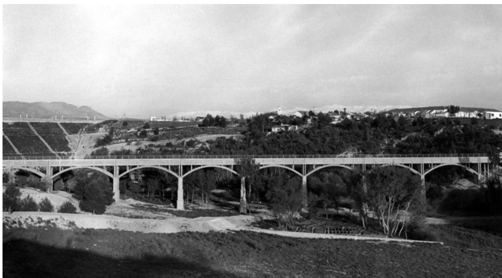
Vista general del acueducto
