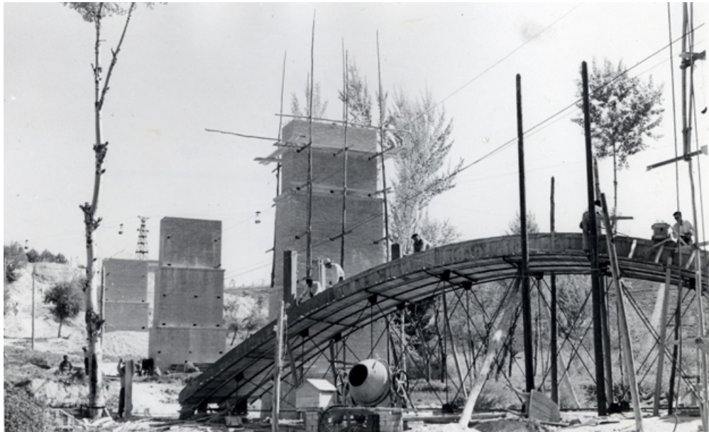
Obreros trabajando sobre una de las estructuras de un arco
