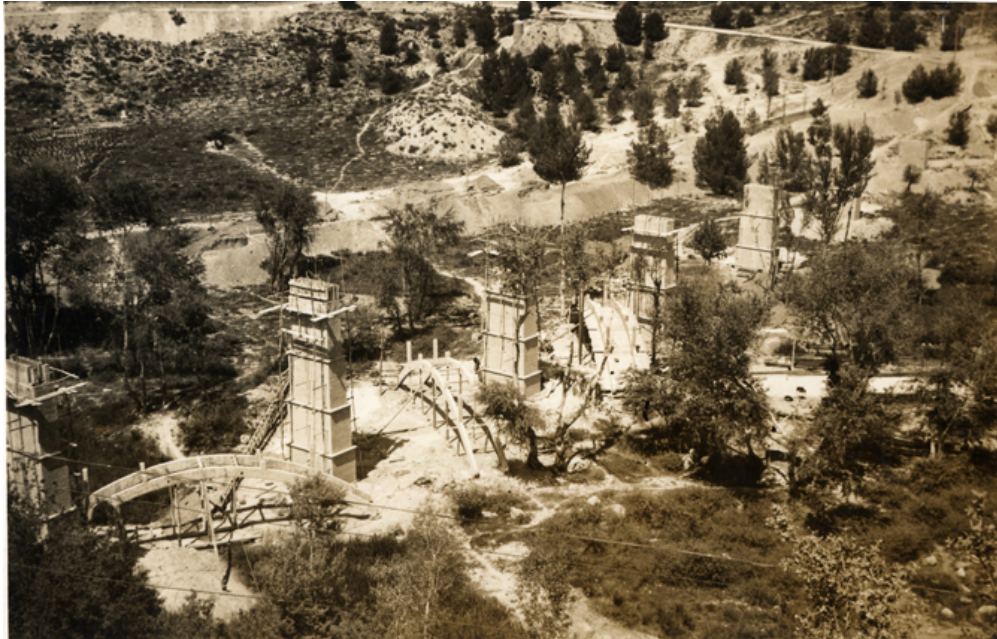
Vista aérea de los pilares en construcción
