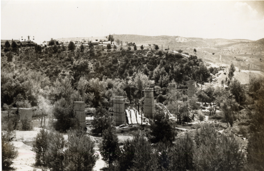
Vista general de los pilares en construcción
