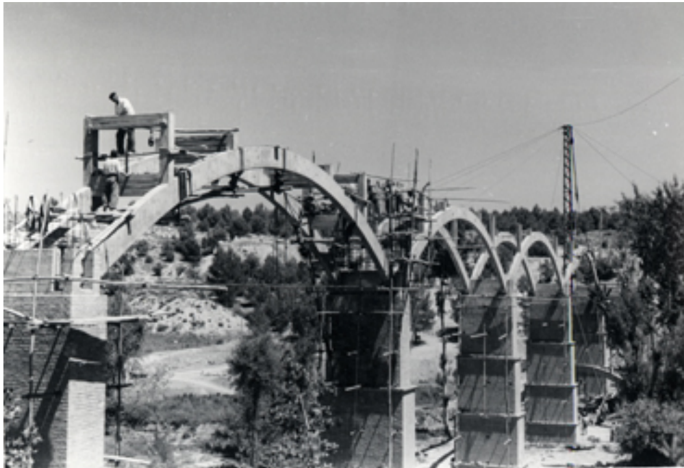
Construcción de los arcos del acueducto
