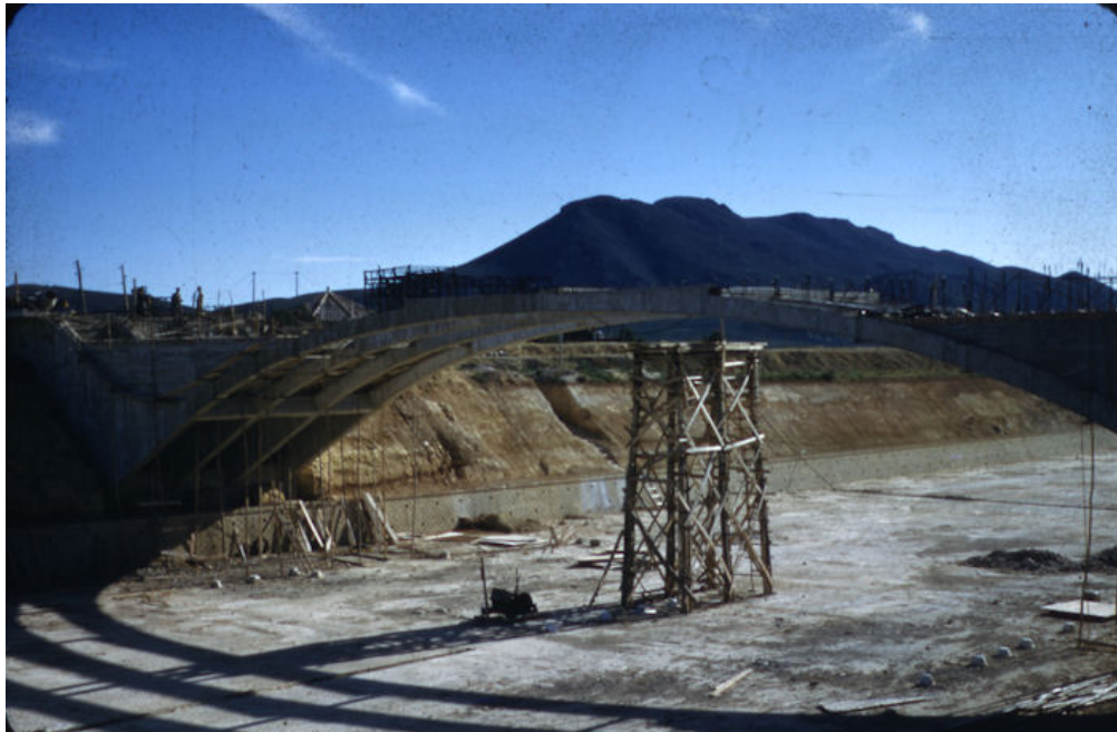
Vista del puente en construcción
