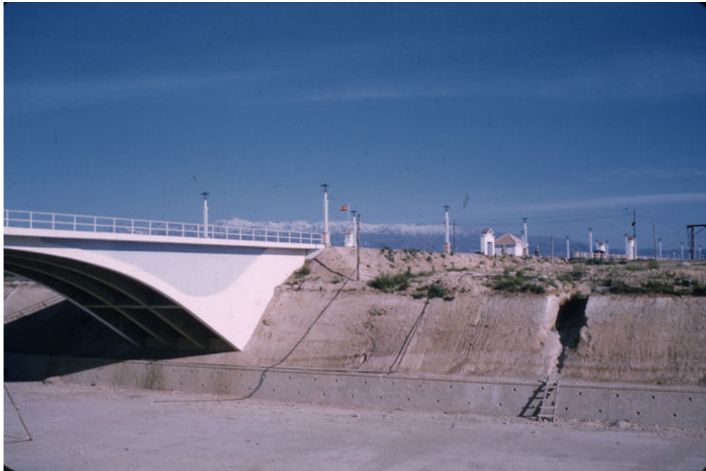
Vista del puente
