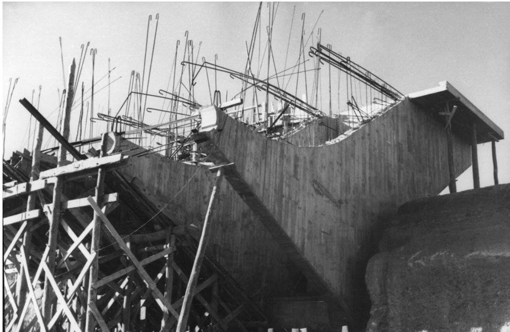
Arranque del arco en construcción
