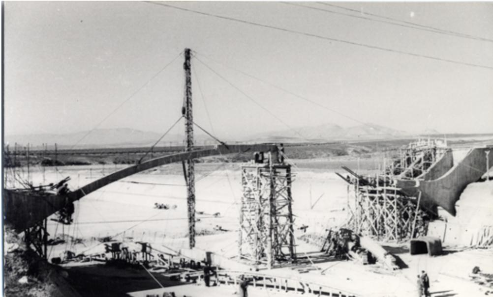
Obreros trabajando en la colocación del primer tramo del puente
