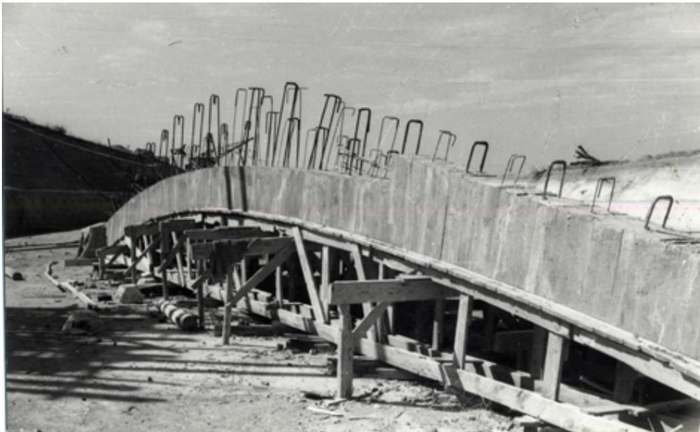
Detalle de una de las secciones del arco antes de ser colocada
